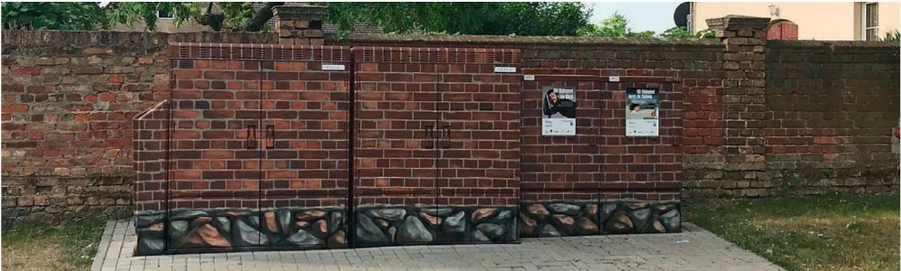
Aus Aluminium gefertigten CCM Multifunktionsgehäuse lassen sich vollflächig gestalten und so perfekt in die standortspezifische Umgebung integrieren.
