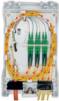
7C Patchkabel gemäß Abbildung führen.
